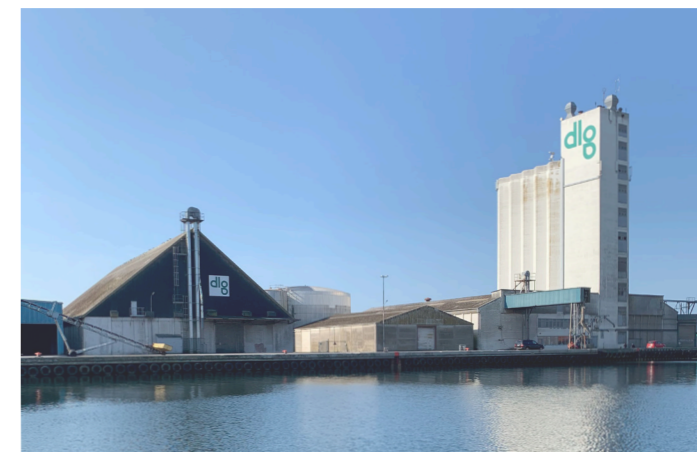
DLG silo og pakhuse, 1960'erne
