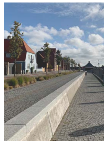
Granitelementer på Nordkajens højvandsmur
