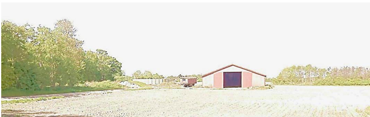
Foto 3.2.6 Ladebygning og gyllebeholder set fra øst på Vejlebyvej.
