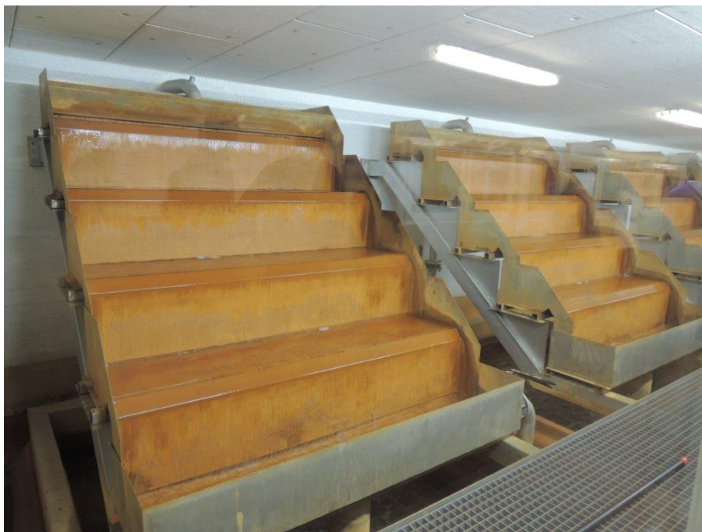
Iltningsstrappe Maribo Vandværk
